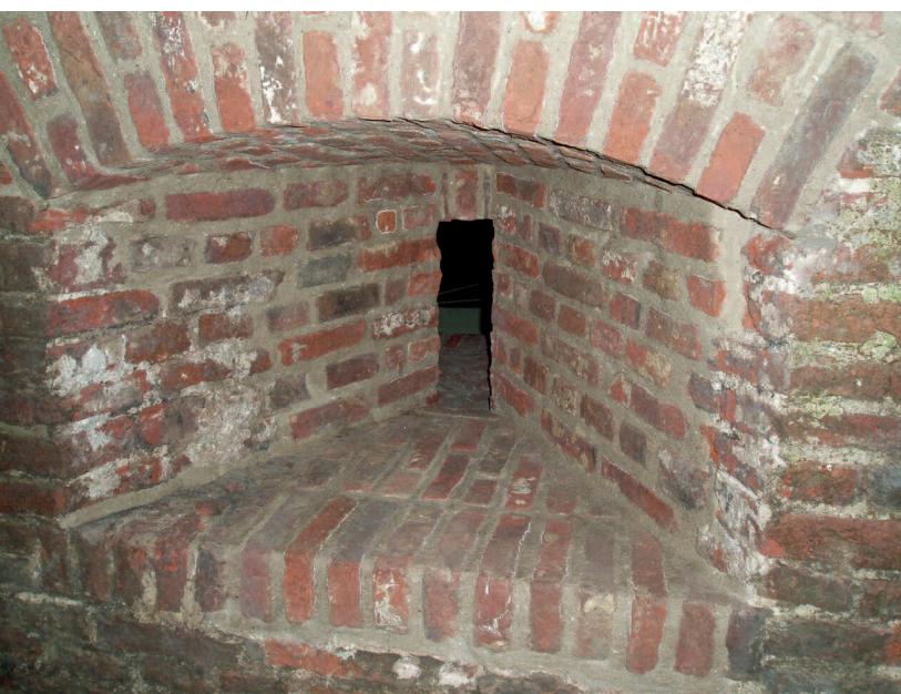
Het gerestaureerde schietgat vanuit de binnenzijde van de toren. (Foto: BAM)
